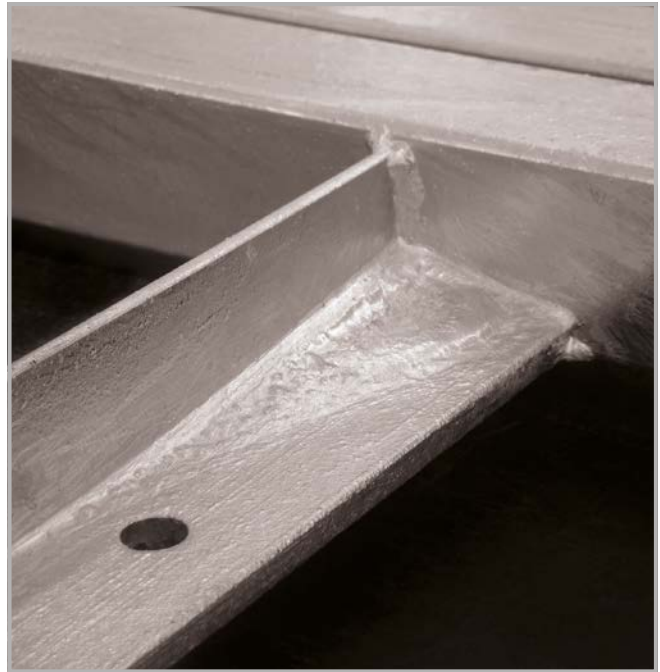
Falta de drenaje en angular
