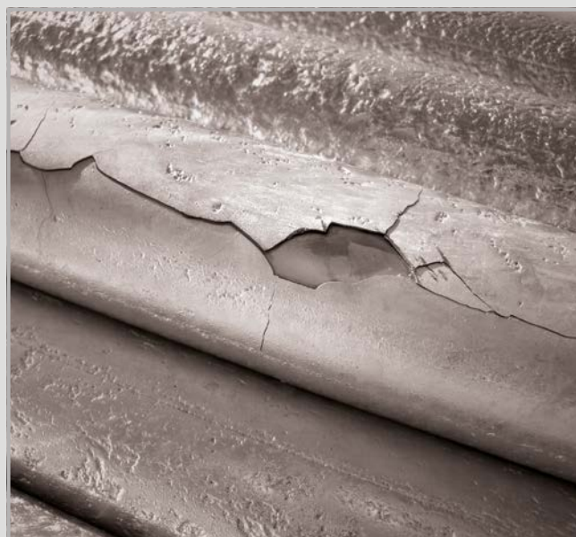
Recubrimiento con falta de adherencia por exceso de silicio.
